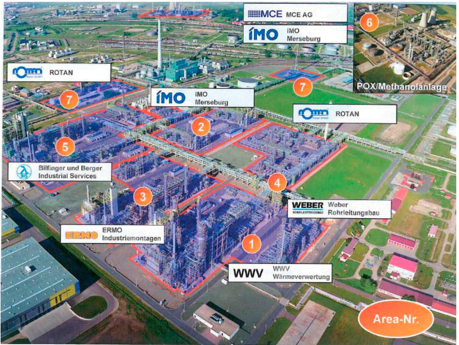
Unitkontraktoren des T&I 2008 in der Übersicht, die Produktionsanlagen sind in Areas unterteilt.
